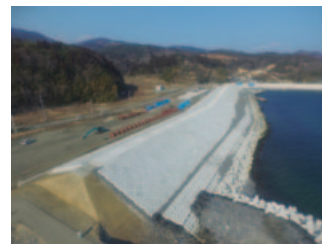
完成全景(終点より)
