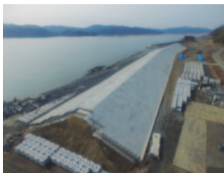
完成全景(起点より)
