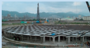
地下部：貯留池の柱・梁・スラブ
