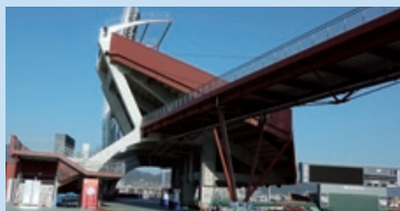
地上部：スタンドを支える「人」形の柱
