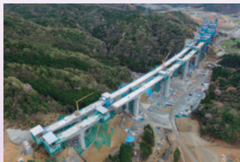
楊梅山高架橋：大阪府(NEXCO西日本 大阪府高槻市)
