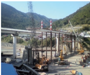
折立橋仮橋設置工事
