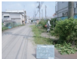
工事現場周辺の草刈作業
