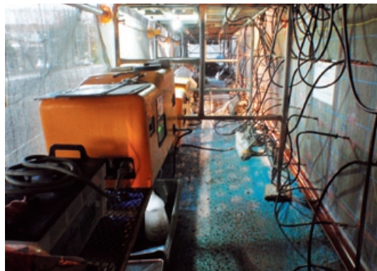
亜硝酸リチウム高圧注入工法 コンクリート構造物への薬液注入状況
