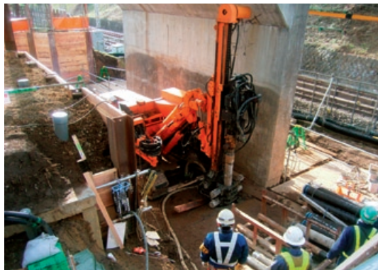
マイクロパイル工法 鉄道に隣接した狭隘地での杭施工
