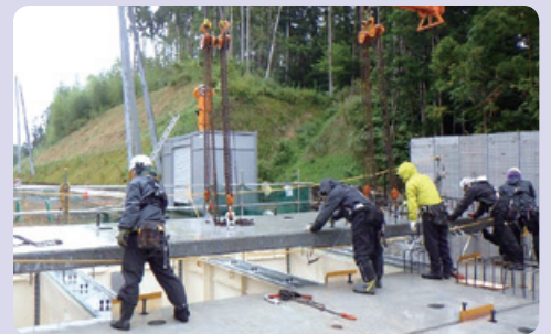
プレキャスト床版架設写真
