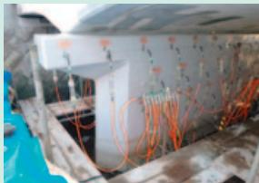
本橋は、玄界灘に注ぐ河川の河口付近に位置する3径間の鉄筋コンクリート橋(橋長15.0m、幅員16.0m)で、著しい塩害環境下に置かれています。調査の結果、コンクリート中に高濃度の塩分が含まれており、塩害による鉄筋腐食が進行していることが判明しました。そこで、塩害補修工法として、弊社の亜硝酸リチウムを内部圧入するリハビリカプセル工法(NETIS:CG-120005-A)が採用されました。
