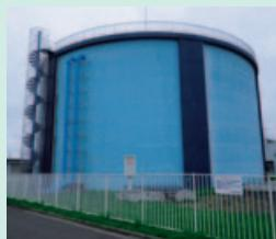
この配水池は、昭和58年から31年間、吉川市内に水を供給するための拠点として使用されていましたが、耐震診断を実施した結果、東日本大震災規模の地震動への耐力が不足していることが判明したため、既設配水池やその周辺施設がある狭隘な場所での施工が可能な高耐力マイクロパイル工法にて基礎の耐震補強工事を行いました。
