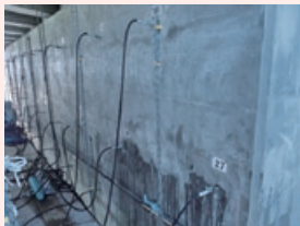
ASRリチウム工法 山内高架橋橋りょう補修工事(佐賀県武雄市)
