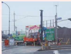
マイクロパイル工法 上矢田南歩道橋マイクロパイル(愛知県西尾市)
