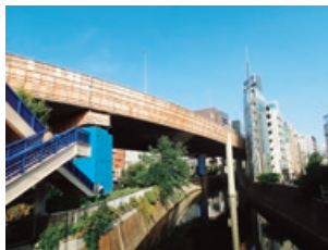
首都高速道路 飯田橋補強(施工中)
