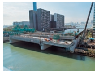
環状2号線 朝潮運河橋梁(施工中)
