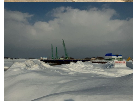
北海道新幹線、岩尾別橋りょう 工期（2024年12月～2026年8月）
