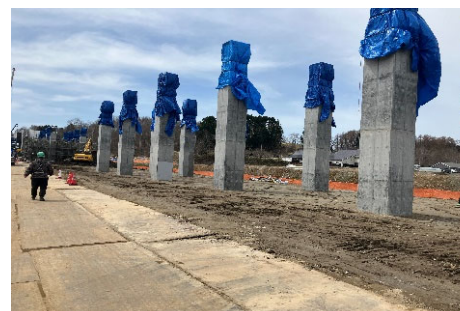
北海道新幹線、ルベシベ川橋りょう 工期（2024年12月～2027年1月）
