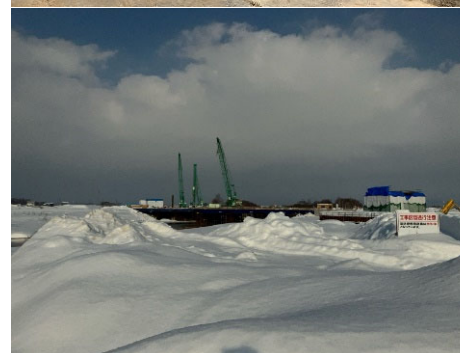
北海道新幹線、岩尾別橋りょう 工期（2024年12月～2026年8月）
