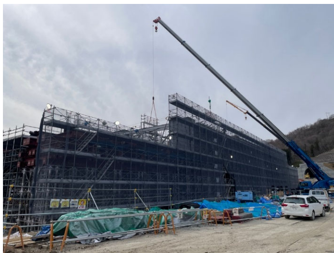
北海道新幹線、遊楽部高架橋 工期（2023年4月～2026年7月）
