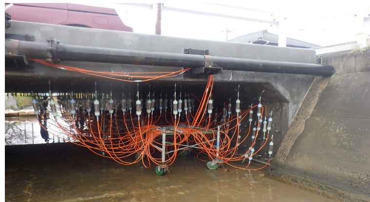
交通規制を伴わないK-LIP工法による床版補修への対応事例
