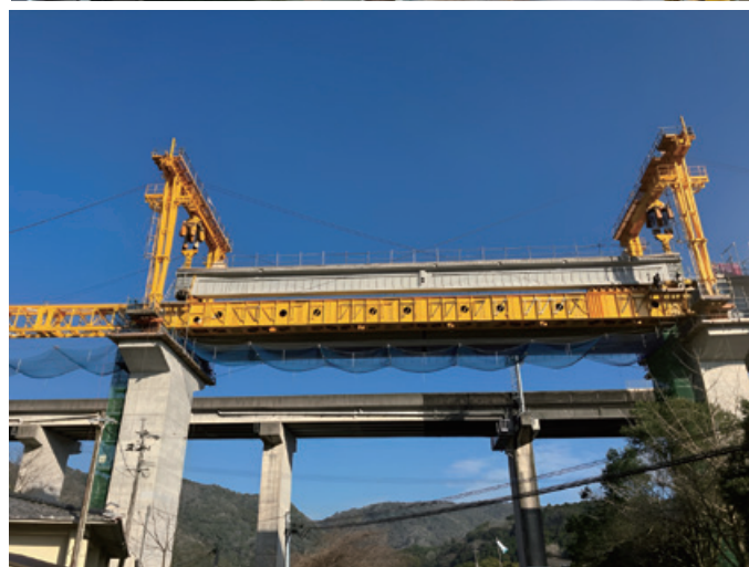
東九州自動車道 香下大橋（大分県）
