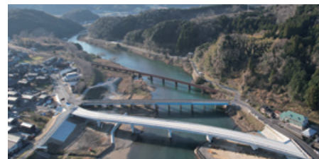
2022年度完成 矢田橋（兵庫県）
