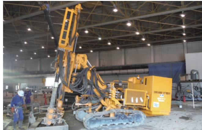
屋内での杭打ち作業
