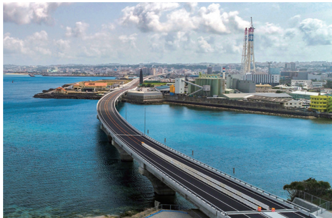
浦添北道路 港川高架橋 (沖縄県)
