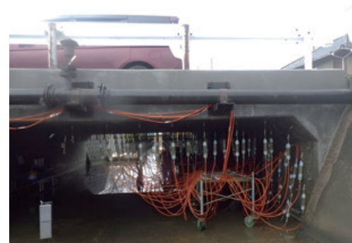
既設橋を供用している状態での補修作業
