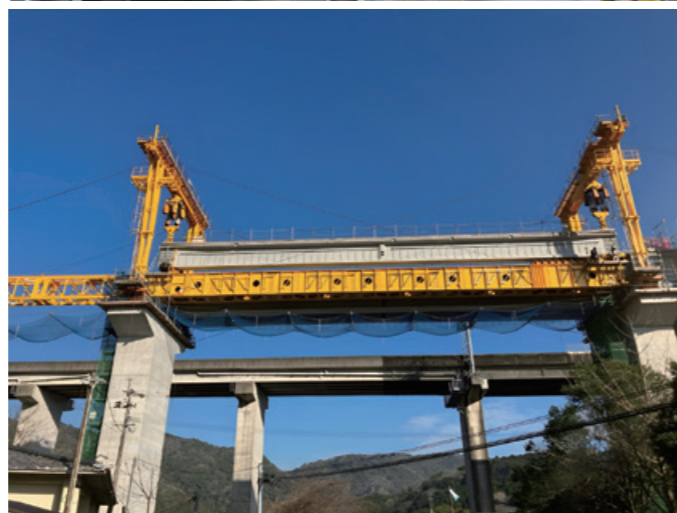
東九州自動車道 香下大橋（大分県）
