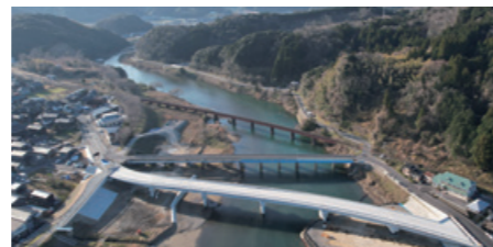
2022年度完成 矢田橋(兵庫県)
