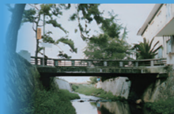
初めてのPC橋・榎橋(広島県) 1954年
