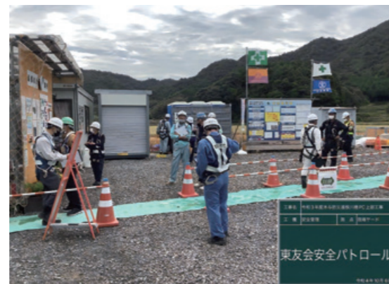
2022年10月、山口県遠根川橋における東友会安全パトロール
