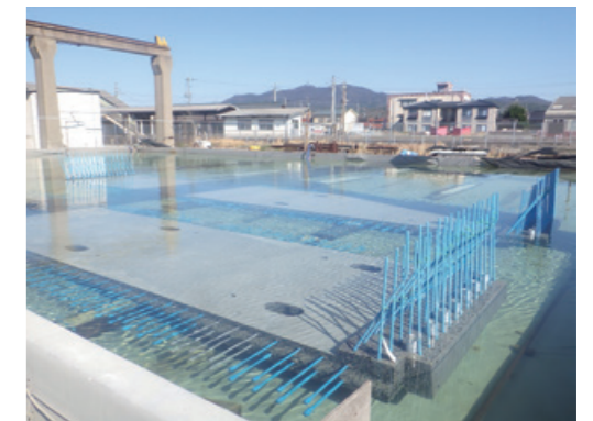
水中養生(プレキャスト製品 道路橋床版)
