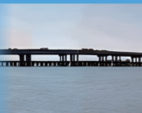
ユーフラテス川架橋(イラク) 1984年
