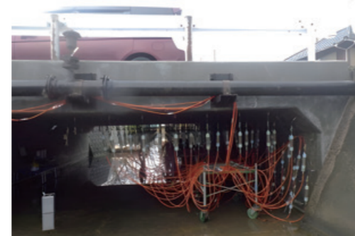
既設橋を供用している状態での補修作業
