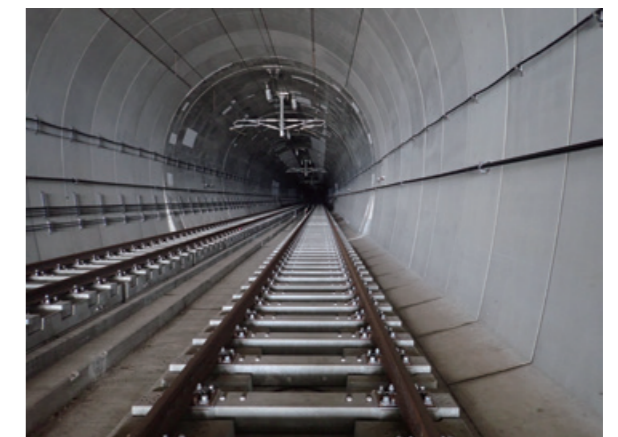
西九州新幹線 大村・長崎間軌道スラブ（長崎県）
