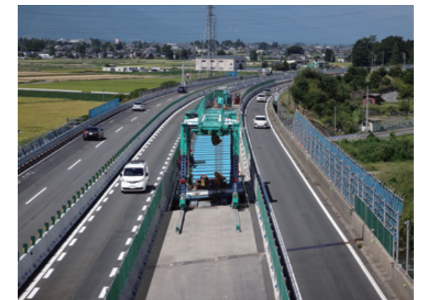
長野自動車道 鎖川床版取替工事（長野県）
