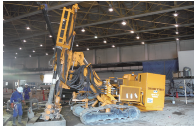
屋内での杭打ち作業
