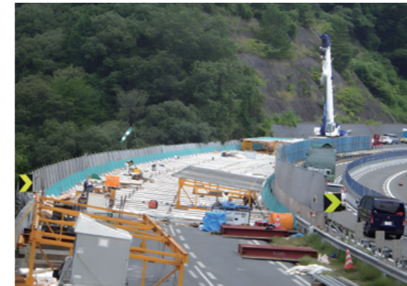
中国自動車道 山田橋床版取替工事 (山口県)
